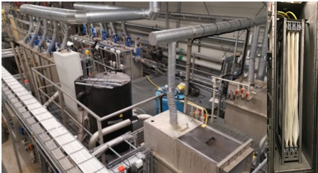
Figur 4. PAK-MBR piloten vid SWIC med de två pilotlinjerna med bioreaktorerna i bakgrunden, de två membrantankarna i förgrunden och permeattanken (svart) till vänster bilden. Till höger en membrankassett med tre membranmoduler.
